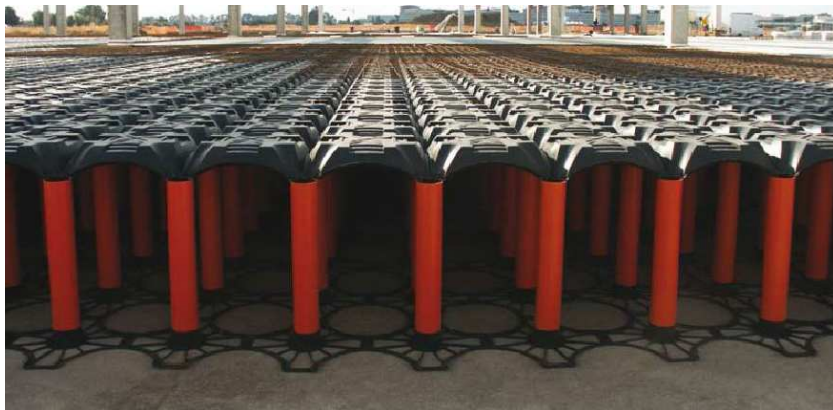
FIG.8 – VESPAIO MODULARE PER INVASI SOTTERRANEI
